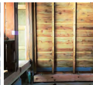
添え梁補強や腐食土台の入れ替えを行い、軸組を補強
