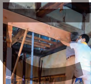
添え梁補強や腐食土台の入れ替えを行い、軸組を補強
